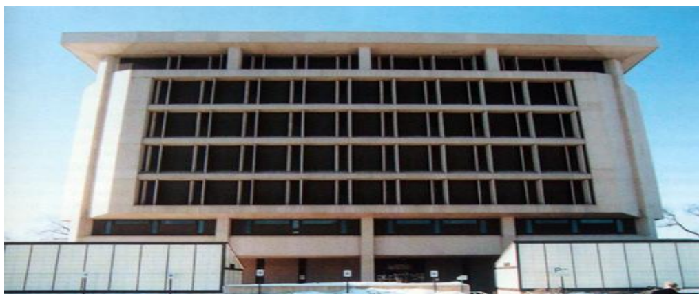
Рис. 1. Восточный фасад первого энергоэффективного высотного здания в Манчестере (США)
